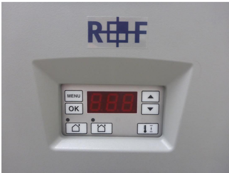
Bild A-24: Bedienteil des Lüftungsgerätes
