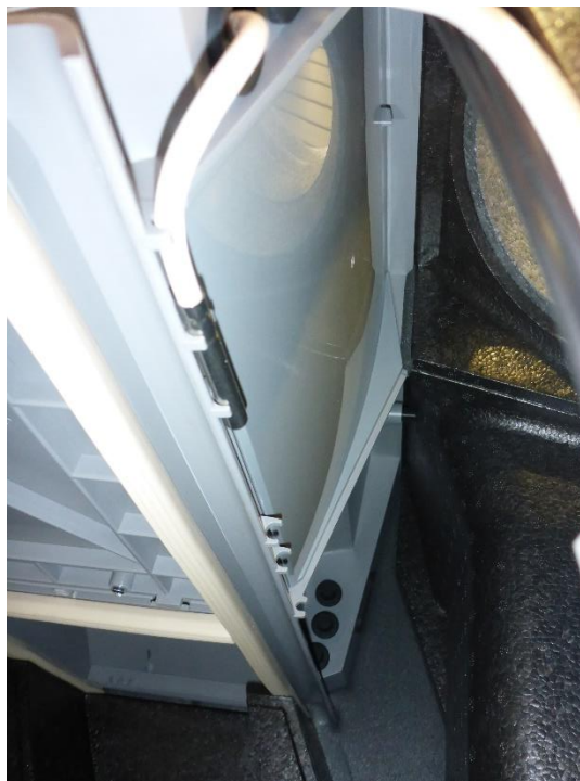
Bild A-21: Klappe vor dem elektrischen Vorheizregister
