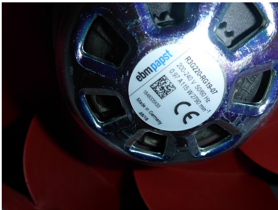
Bild A-19: Typenschild des Fortluftventilators
