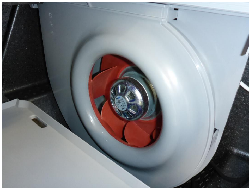
Bild A-18: Fortluftventilator des Lüftungsgerätes
