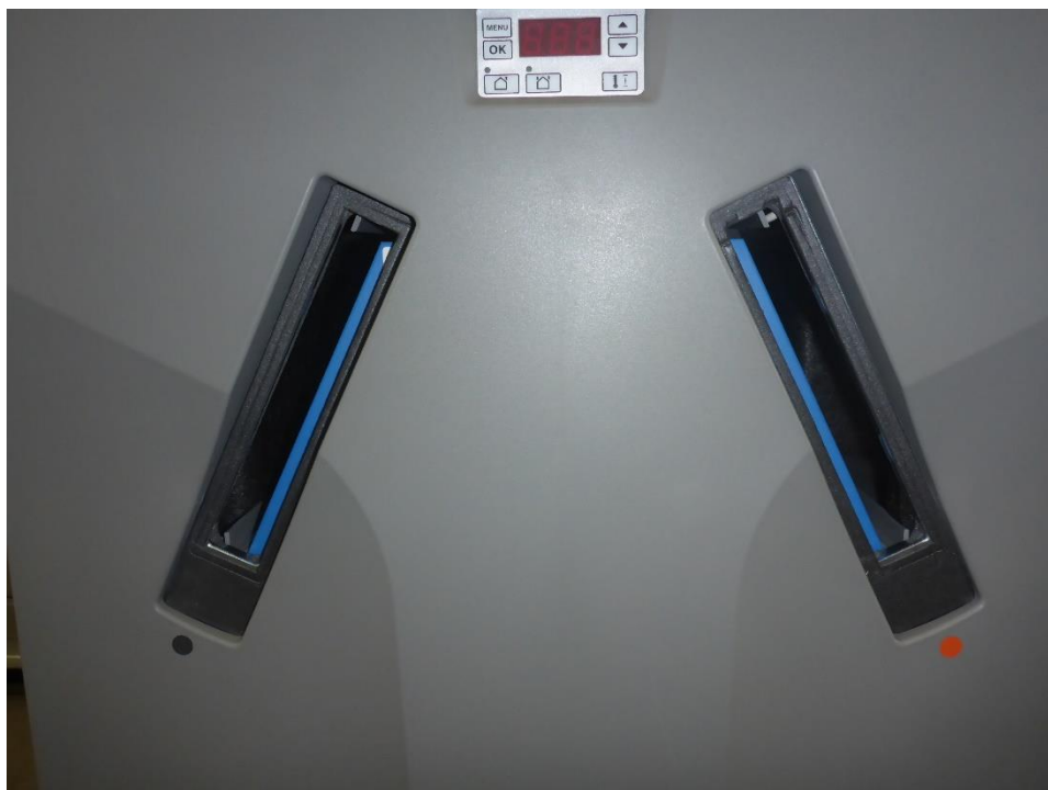
Bild A-6: Filtereinschübe mit herausgezogenen Filtern
