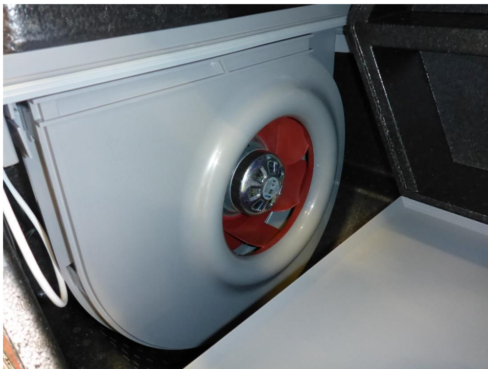
Bild A-16: Zuluftventilator des Lüftungsgerätes
