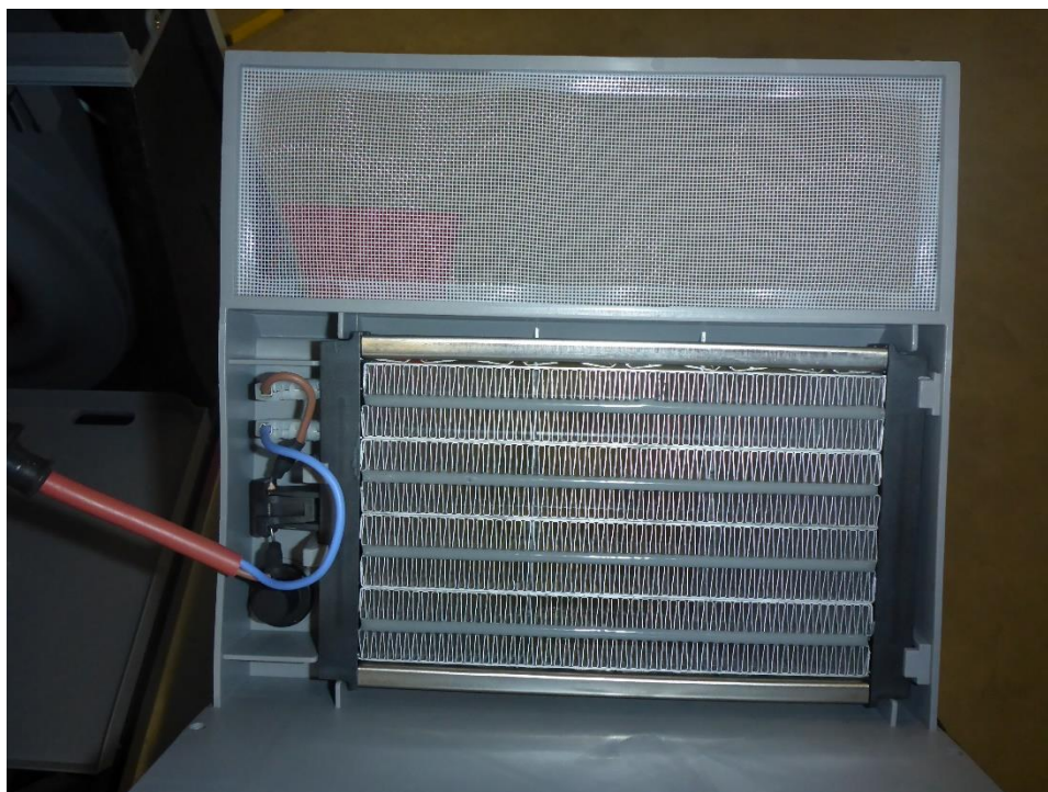
Bild A-22: Elektrisches Vorheizregister des Lüftungsgerätes
