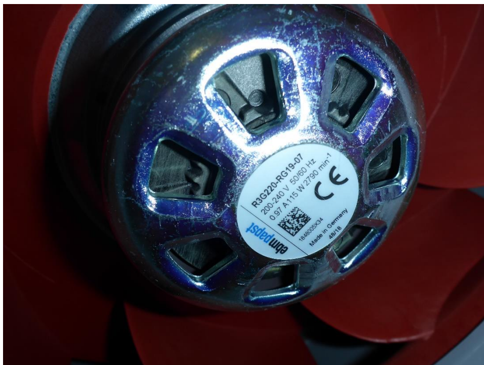
Bild A-17: Typenschild des Zuluftventilators
