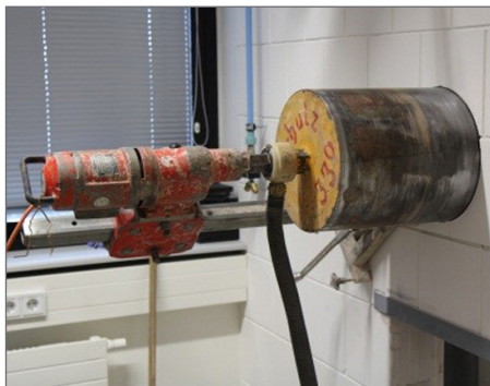
Fig. 2 - Perçage de l'avant-trou
