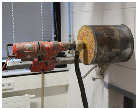
Fig. 2 - Foro di carotaggio
